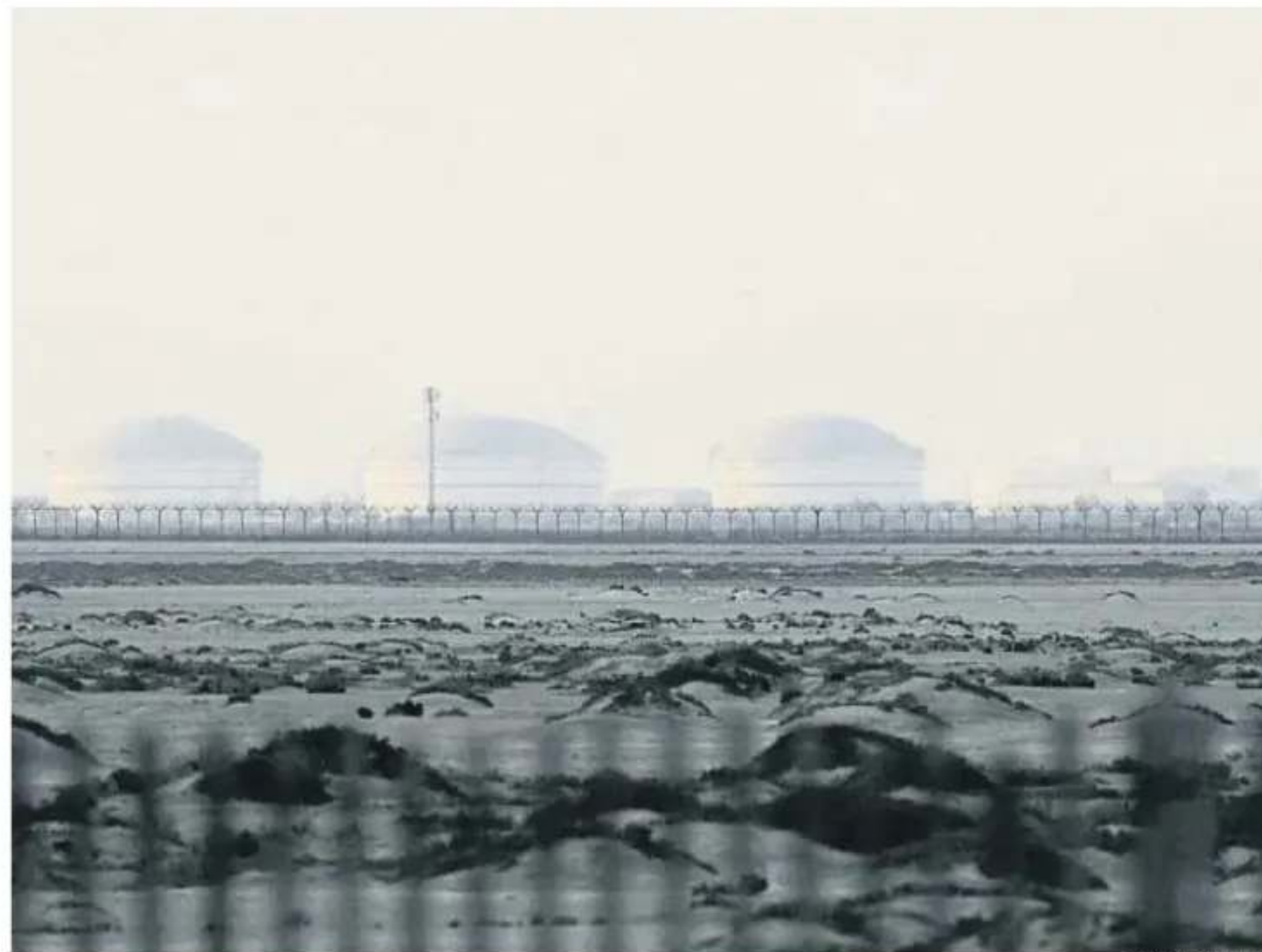
Instalaciones gasistas en Ras Laffan, Qatar, uno de los complejos atacados y paralizados
